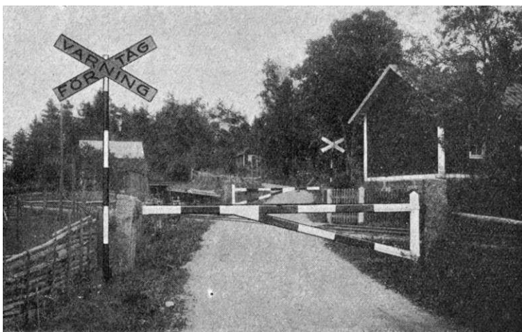
Väggorsning med kryssmärke och av vakt bevakade svängbommar.
