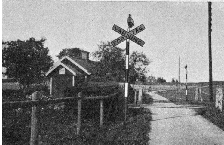
Vätkorsning med kryssmärke och automatiskt ringverk för eu spår.
