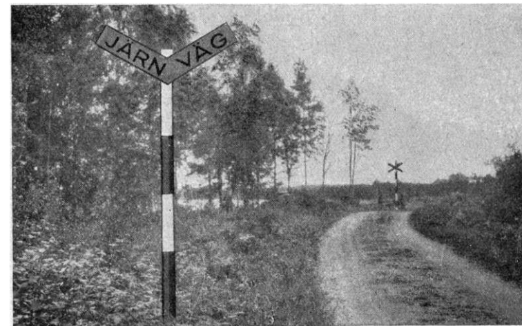
Vägkorsning med förvarningsmärke och kryssmärke.
