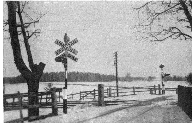
Väggorsning med kryssmärke och automatisk ljussignal (Samt ljud-JSignal för flera spår.
