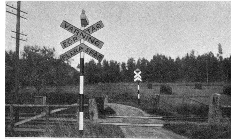
Vätkorsning med kryssmärke och automatiskt ringverk för flera spår.
