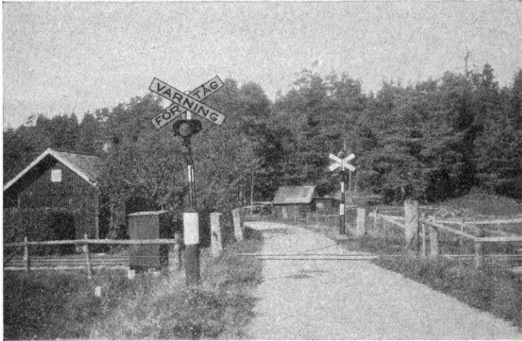
Väggorsning med kryssmärke och automatisk ljussignal för ett spår.
